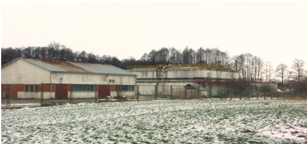
Fot. 1. Istniejąca oczyszczalnia ścieków
